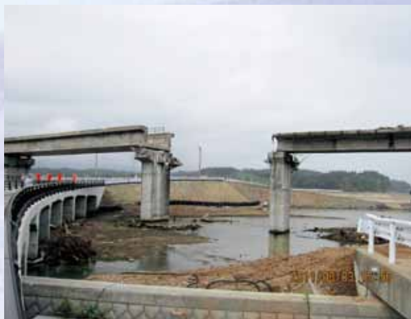
流されたままの気仙沼線の橋梁
