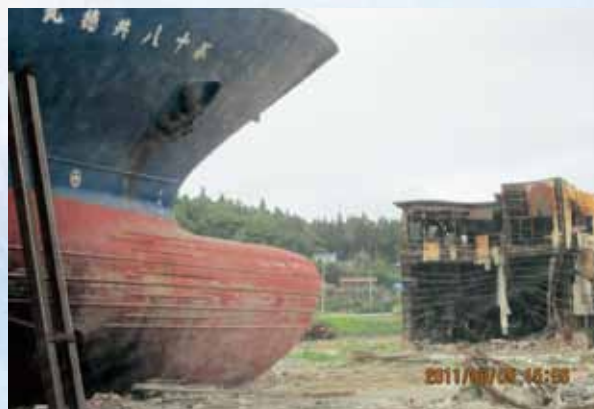
港から数百mも流されたままの大きな漁船に睨まれるような2階建ての建物
